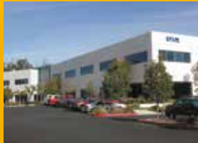
FLIR Santa Barbara, USA
